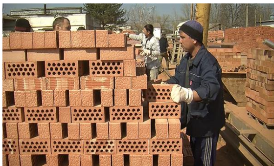
Укладка кирпича на заводе ООО «Пламя»
